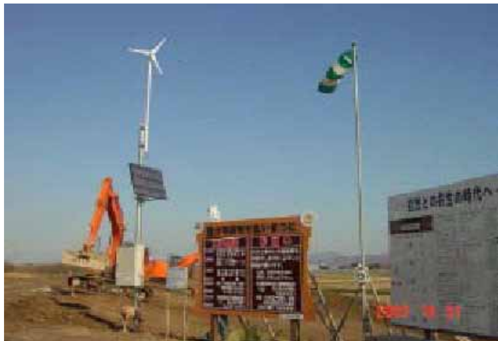
標示板電源（風力・太陽光発電システム）設置状況
