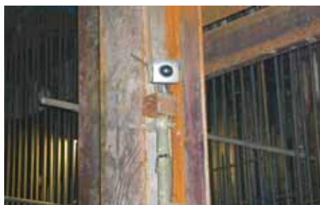
リアルタイム Web カメラ設置状況
