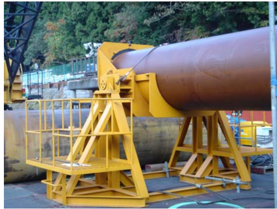
吊り起こし架台
