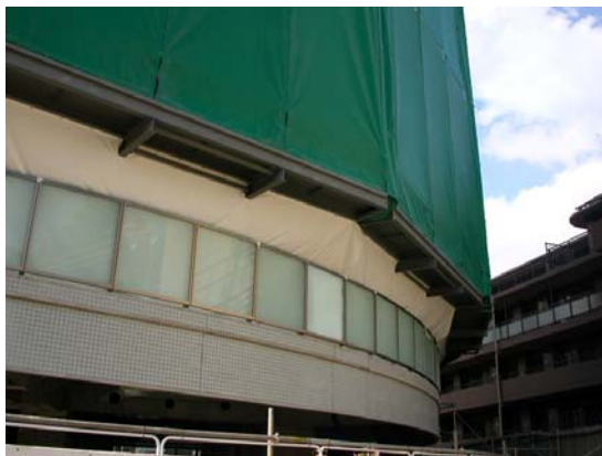
最下部養生シート設置状況
