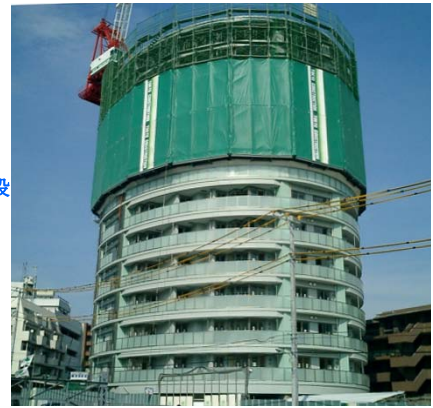
クライミング足場全景
