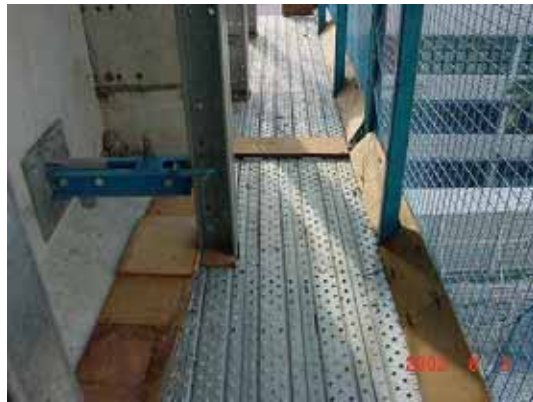
システム足場取付状況
