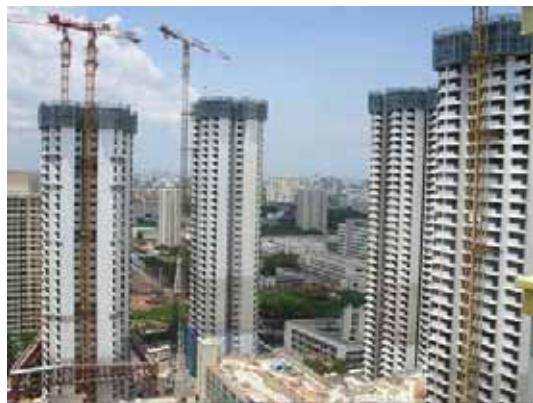
システム足場全景
