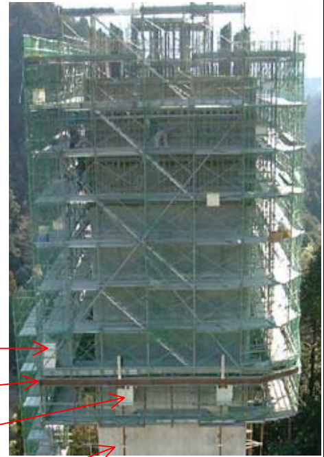
作業ステージ状況
