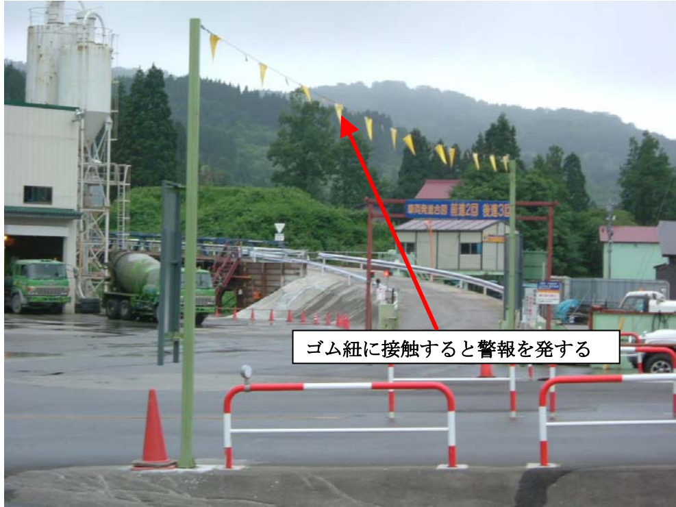
②現場出入口に設置した高さ制限装置(ゴム紐式)
