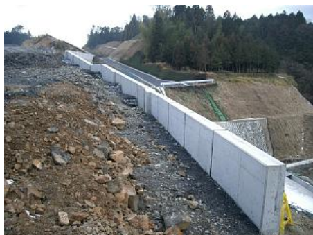
⑦コンクリート打設後脱型状況
