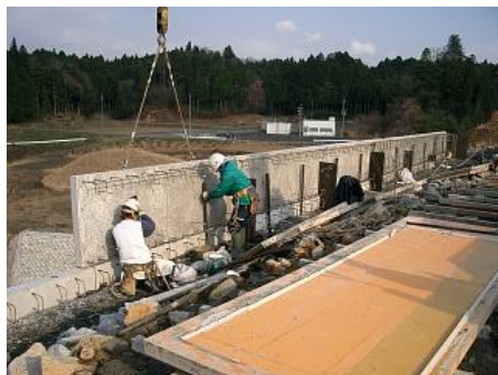
③現場打ちプレキャスト部材揚重建て込み(1次) ④現場打ちプレキャスト部材を下部スチと連結固定
