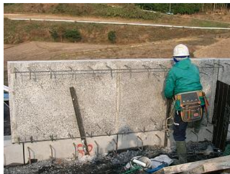
③現場打ちプレキャスト部材揚重建て込み(1次) ④現場打ちプレキャスト部材を下部スチと連結固定
